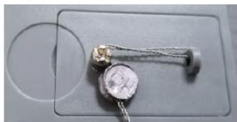
Sellado mediante cable
