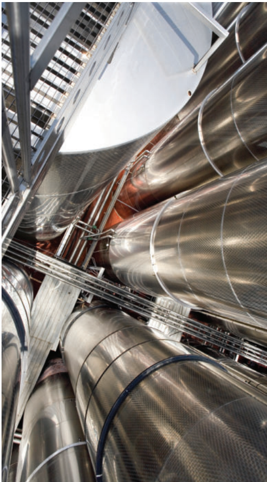
Silo, bồn chứa và phễu
